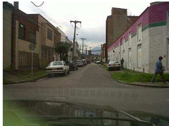
Foto N° 4. Se evidencia desgaste y fatiga de materiales.
